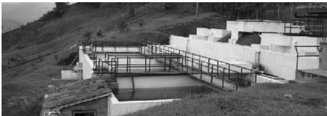
Planta Municipal de Tratamiento de agua potable
